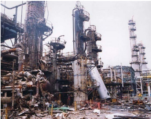
Fig.1.2 Explozie într-o rafinărie în SUA, datorită unei fisuri în ZIT în cusătura sudată la o conductă dintr-un recipient de alchilare, datorită conținutului ridicat de hidrogen dizolvat în cusătură.
