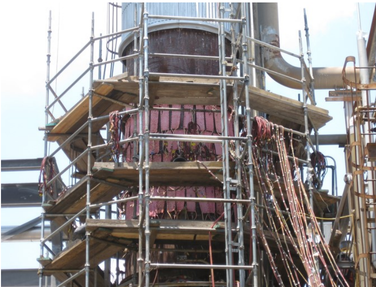
Fig. 6.11 Preîncălzirea unor structuri metalice de gabarit ridicat.
