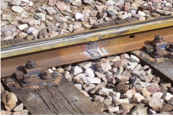
Fig. 4.93 Sudarea aluminotermică a șinelor de cale ferată.
