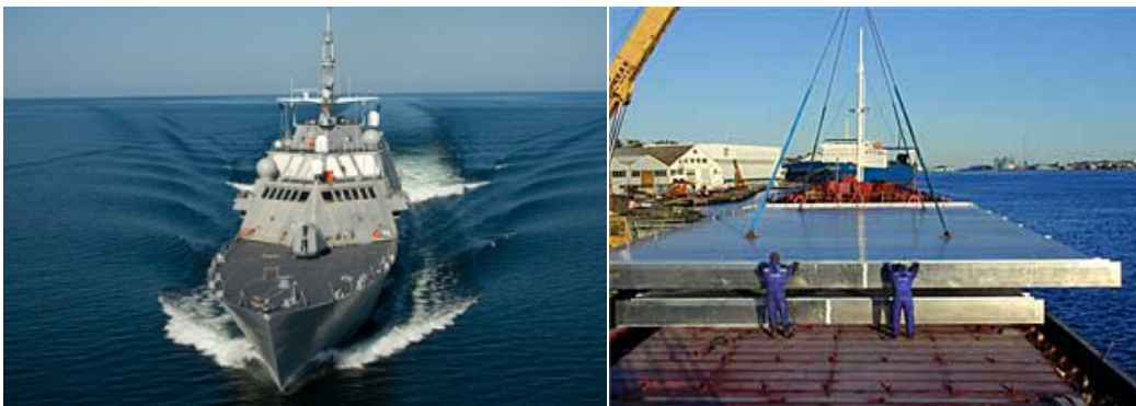
a) Nava USS Freedom a cărei structură este realizată din panouri de Al, sudate prin FSW.
