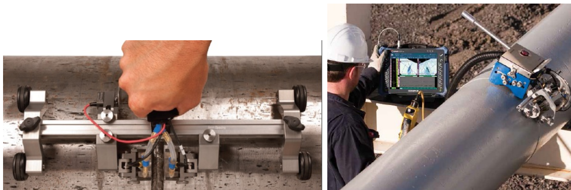
a) Examinarea cusăturii sudate prin TOFD 1 . Scanare semiautomată
