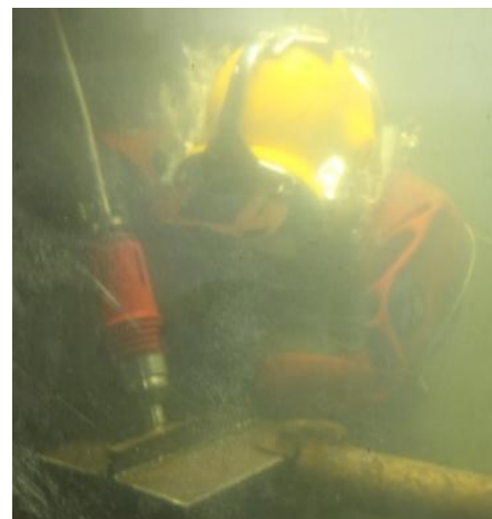
b) structură metalică sub apă
