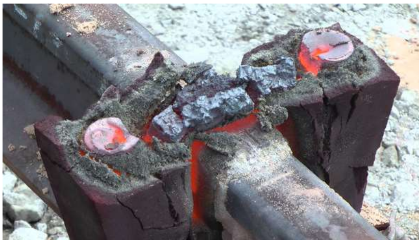
Fig. 4.96 Aspectul îmbinării sudate, după îndepărtarea dispozitivului de sudare cu termit.
